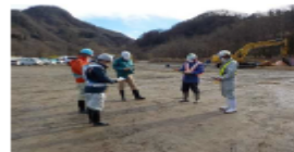
工事概要の説明
