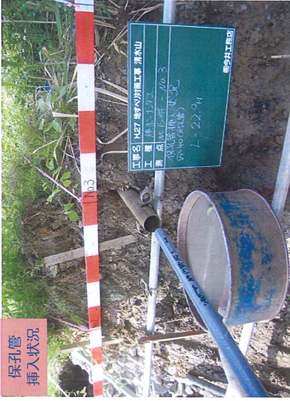
保孔管 挿入完了
