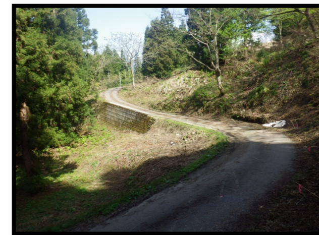
【県道拡幅工】着手前
