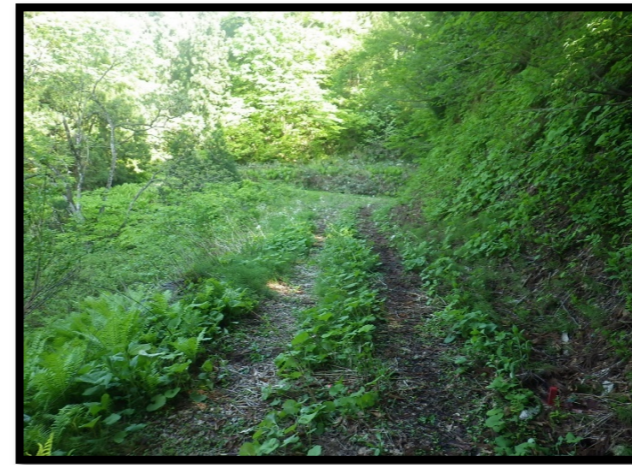
【迂回路工】着手前
