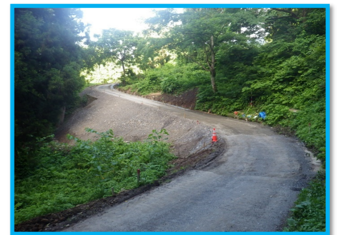
【県道拡幅工】施工中
