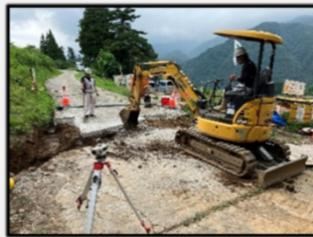
増工により、現場近くの道路の舗装を壊し、パイプの新設を行う作業が始まりましたが、堰堤の施工も同時進行で行っております。石を敷き詰めたかごの設置や切土法面の植生シート・マットの貼付等、まだまだしなくてはならない事はありますが、堰堤の施工はようやく折り返しに入りました。現在、3つ目の側壁工をつくっております。この作業が終わった後は、水が通る部分(水通し)の施工を行う予定です。
