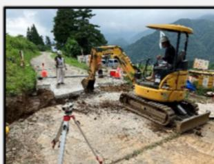
増工により、現場近くの道路の舗装を壊し、パイプの新設を行う作業が始まりましたが、堰堤の施工も同時進行で行っております。石を敷き詰めたかごの設置や切土法面の植生シート・マットの貼付等、まだまだしなくてはならない事はあります。堰堤の施工はようやく折り返しに入りました。現在、3つ目の側壁工をつくってあります。この作業が終わった後は、水が通る部分(水通し)の施工を行います。
